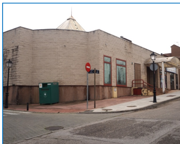
2. Edificación El Zoco. Fachada oeste c/Bilbao.
