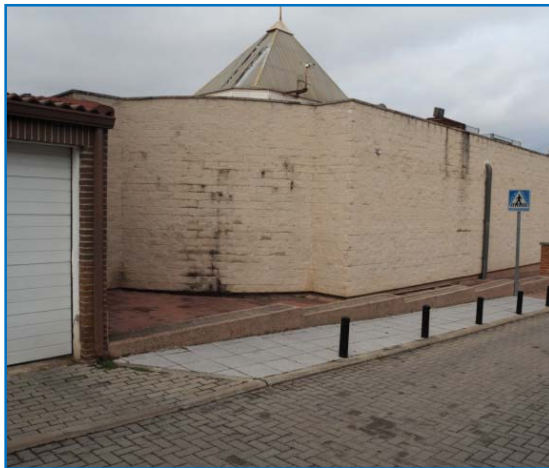
3. Edificación El Zoco. Fachada este c/Ávila.
