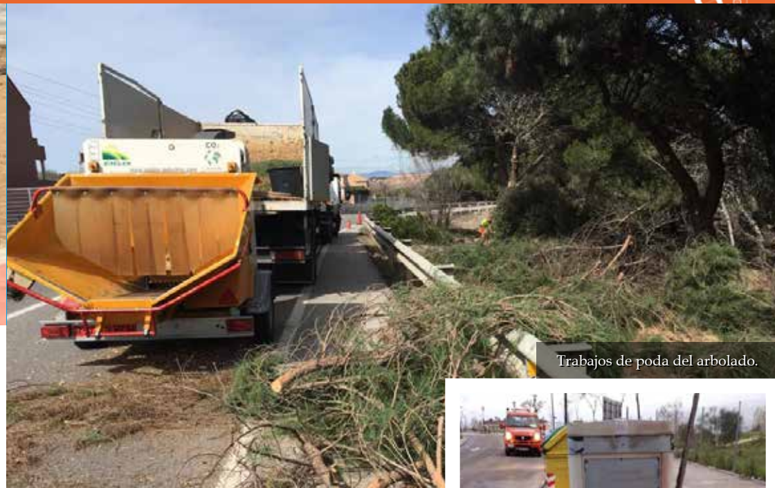
Preparación de la acera para la colocación de nuevas marquesinas de autobuses.
